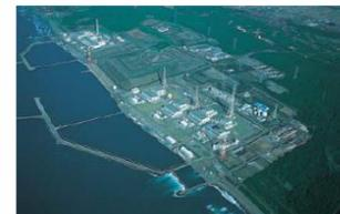
Centrale progettata per resistere a un'accelerazione orizzontale di 274 gal (centimetri al secondo quadrato), in base ai "precedenti sismici" della zona. La scossa, di magnitudo 6,6 sulla scala Richter, ha invece provocato un'accelerazione di 680 gal a livello del primo reattore
